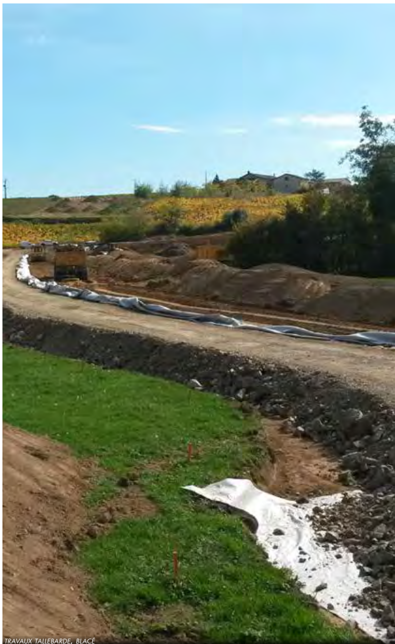
TRAVAUX TALLEBARDE, BLACÉ
