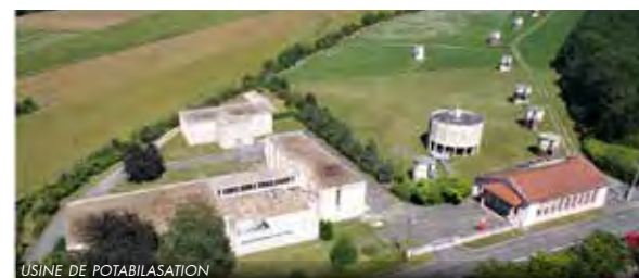
USINE DE POTABILISATION
