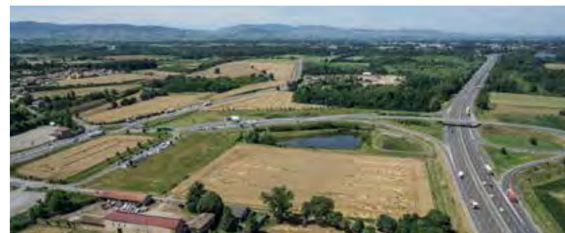
Vue aérienne de la future ZAC Ile Porte à Arnas
