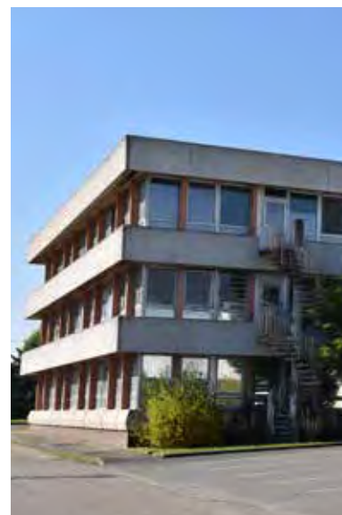
Bâtiment du futur pôle numérique
