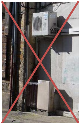
Appareils divers en applique sur la façade
