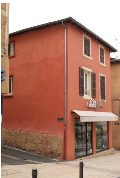
enduit traditionnel à la chaux rue Nationale
