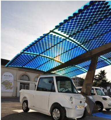
« ombrières » photovoltaïques sur un parking
