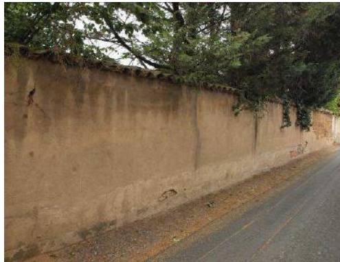
exemple de mur maçoné enduit et protégé par une couverture en tuiles creuses
