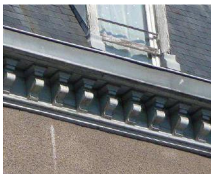
corniches bois à modillons formant dépassées de toiture
