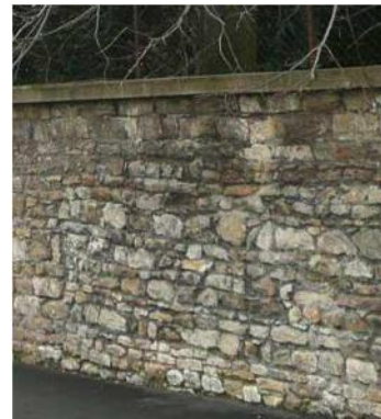
exemple de mur maçoné en pierre à bâtir destiné à être enduit...
