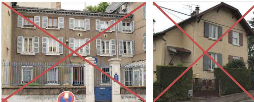
façade aux menuiseries hétérogènes
