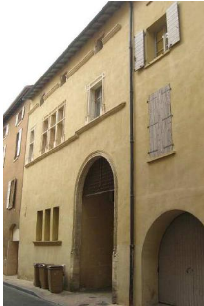
Edifice traditionnel construit avec des matériaux thermiquement efficaces...
