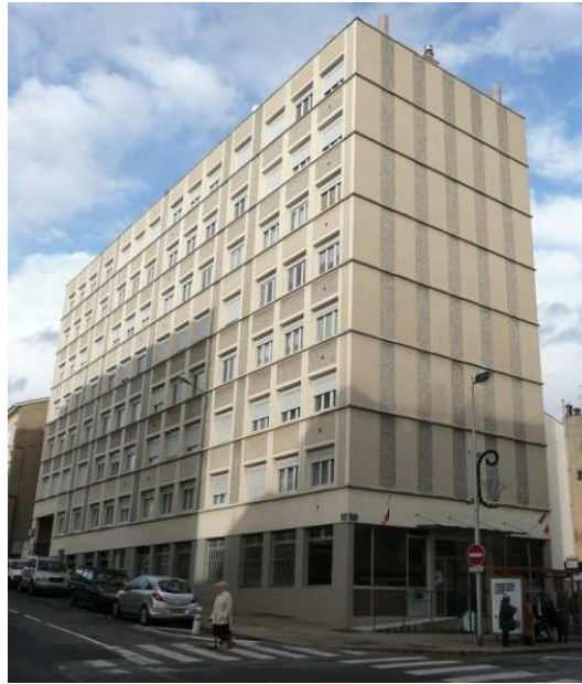
Immeuble des années 1970 construit avec des matériaux industriels et peu isolants...
