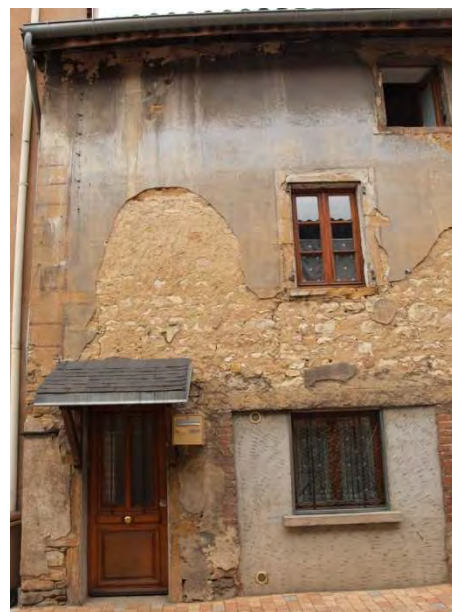
L'enduit est la « peau » de l'édifice, sans lui la structure n'a plus de protection...
