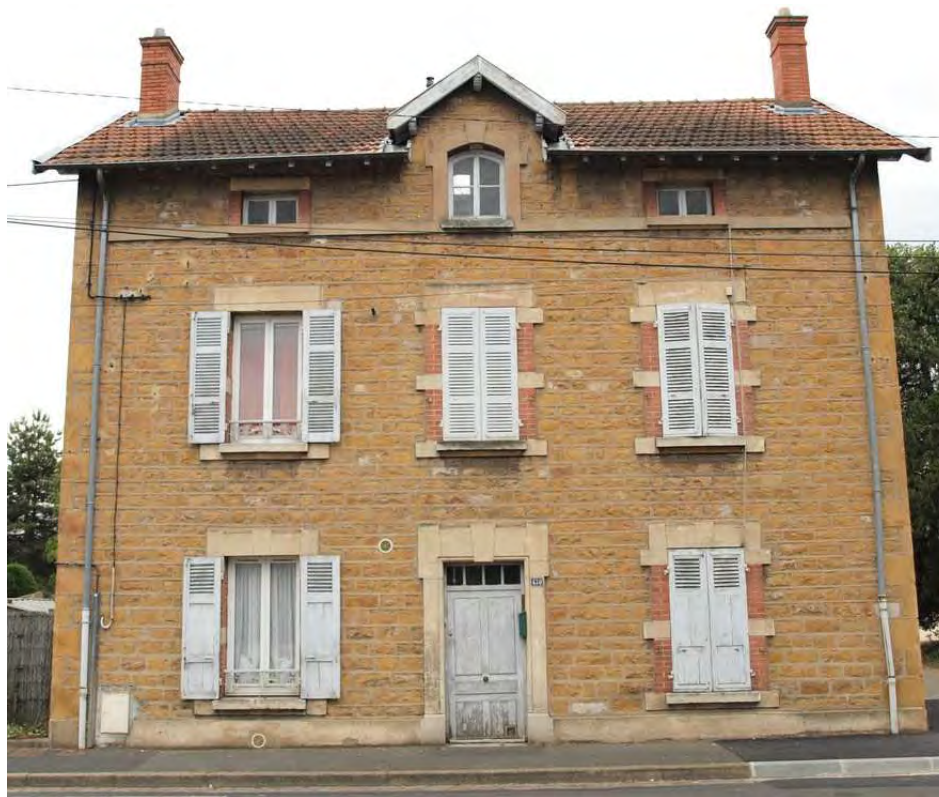
Maison en « pierres dorées » équarries avec un joint débordant. Les encadrements en pierre de taille très débordant laissent penser que cette façade est destinée à être enduite
