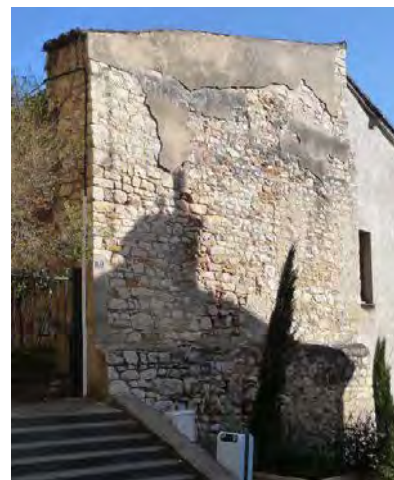
Exemple de maçonnerie épaisse en pierre avec une grosse inertie thermique
