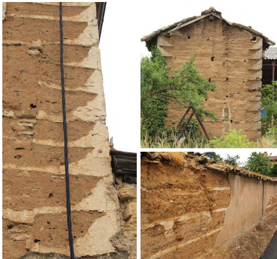
Exemples de constructions en pisé (bâtiments et murs de clôture) sur le territoire caladois
