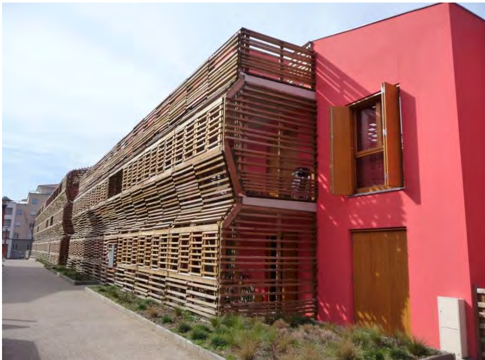
Exemple d'utilisation du bardage bois dans l'architecture contemporaine, il est important de faire la distinction entre matériaux traditionnels et formes traditionnelles, deux notions complètement indépendantes
