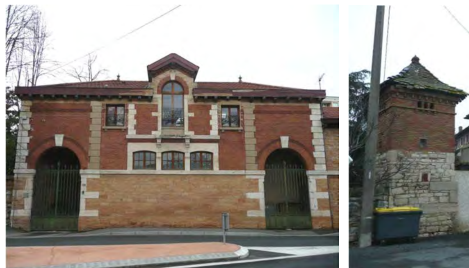
Communs (probablement les écuries) du domaine de Pontbichet en alternance de briques et de pierres Pigeonnier en pierres et briques à Beauregard
