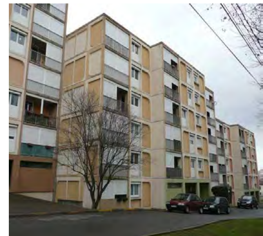
Exemple de construction des années 1960-1970 en matériaux de synthèse aux capacités d'isolation faibles
