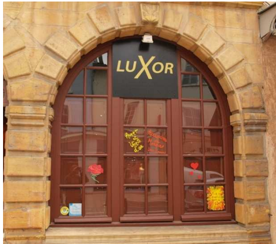
Baie en pierre de taille de l'ancien Hôtel de Ville
