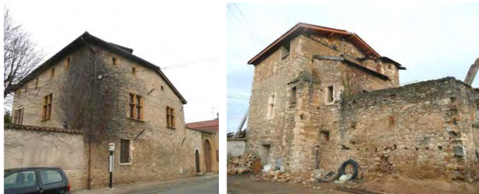
Maison en du XVI e siècle en maçonnerie de pierres à bâtir devant être enduite... Maison en maçonnerie de pierres à bâtir devant être enduite...
